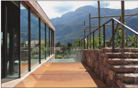
Kellerei Terlan, Gebäudeachse
